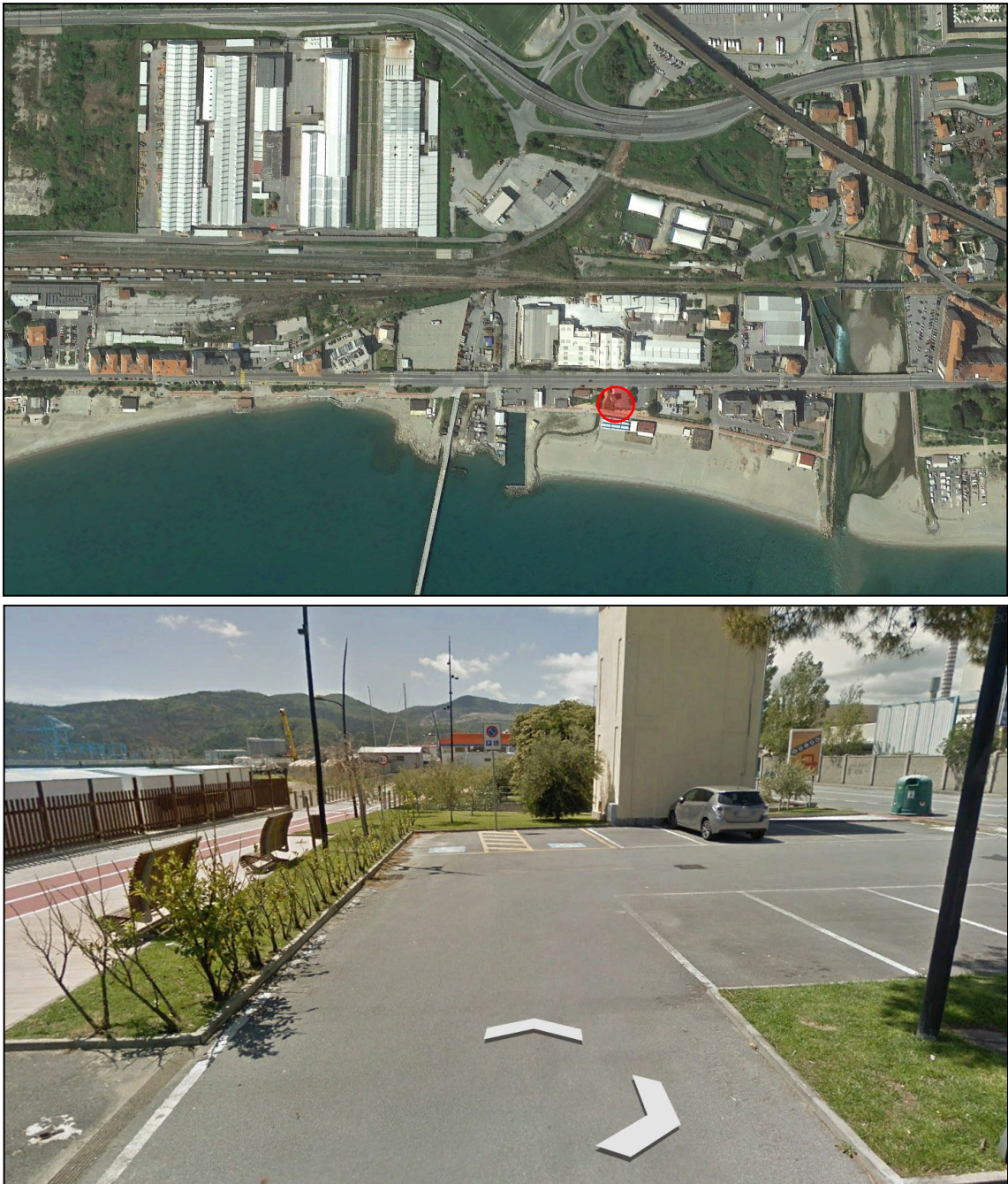
Figura 5 – Individuazione del sito n°4 e vista generale dell’area.
