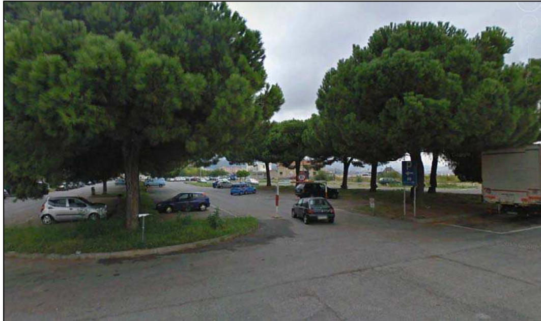
FIG. 2.5 - STATO DI FATTO IN CORRISPONDENZA DEL PIAZZALE DI SAN LORENZO - LE TUBAZIONI INTERRATE INTERFERISCONO COL SEDIME DI PARCHEGGIO IN FASE DI REALIZZAZIONE
