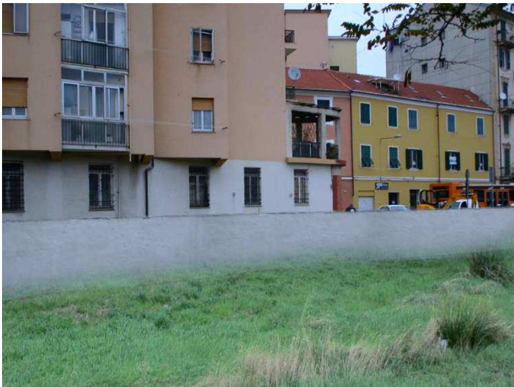
Figura 18 c): Tratto 4 - Vista 2 – Post Operam
