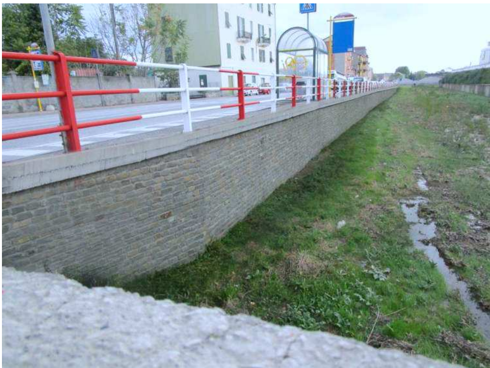
Figura 15 c): Tratto 1 - Vista 1 – Post Operam
