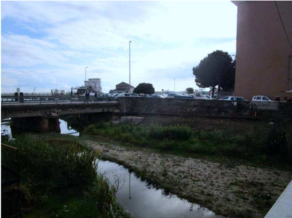
Figura 7 c) Tratto 5 - Vista 3
