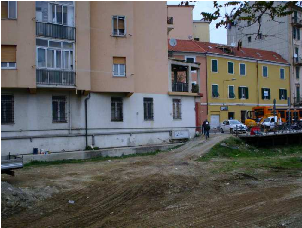
Figura 18 b): Tratto 4 - Vista 2 – Ante Operam
