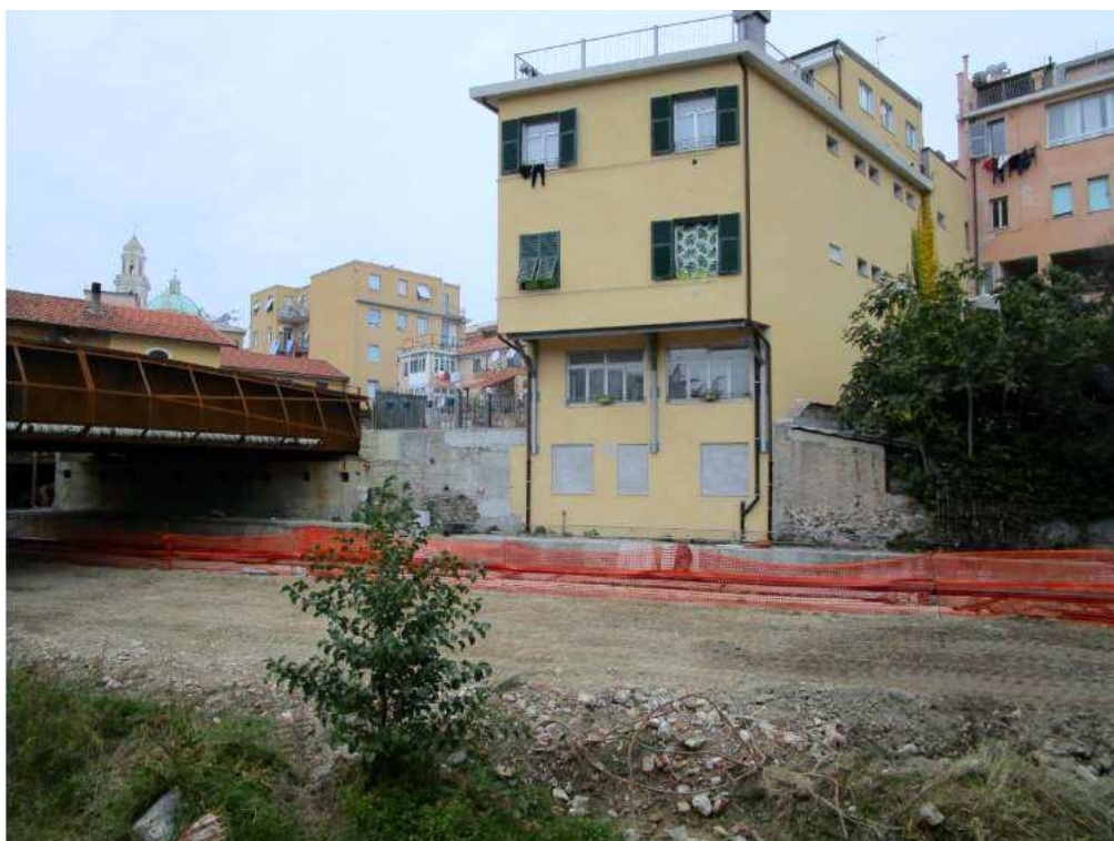
Figura 6 d): Tratto 4 - Vista 3
