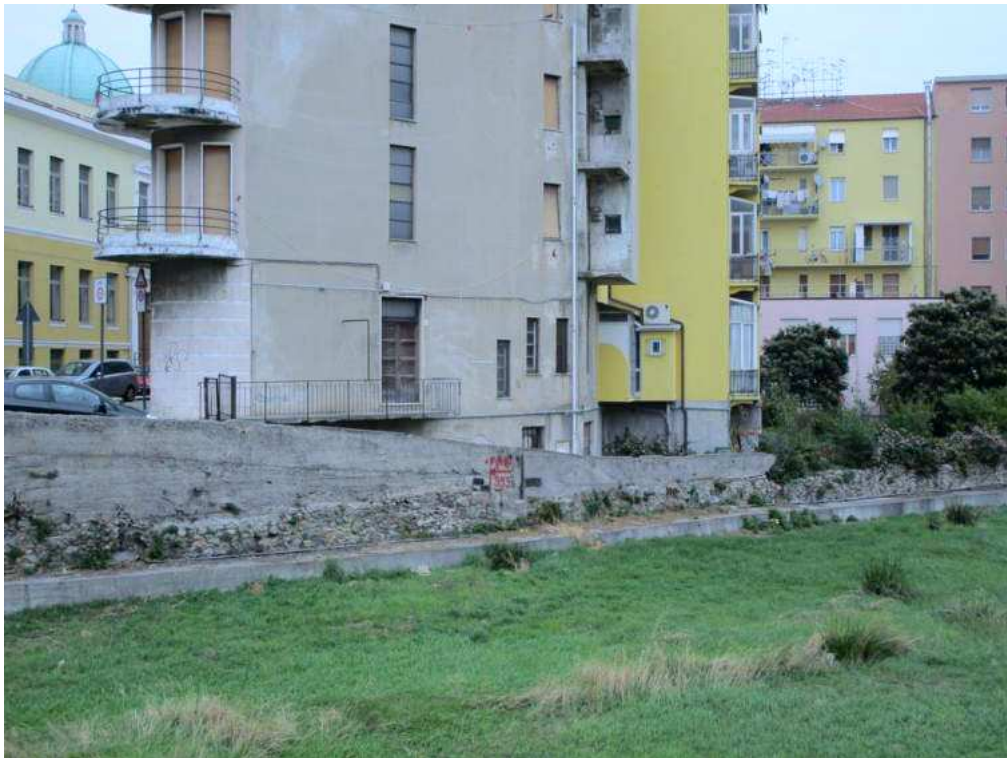
Figura 17 b): Tratto 3 - Vista 5 – Ante Operam
