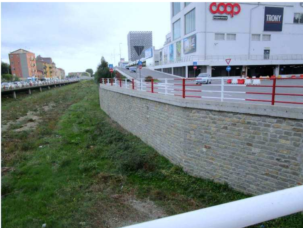
Figura 3 c): Tratto 1 - Vista 2
