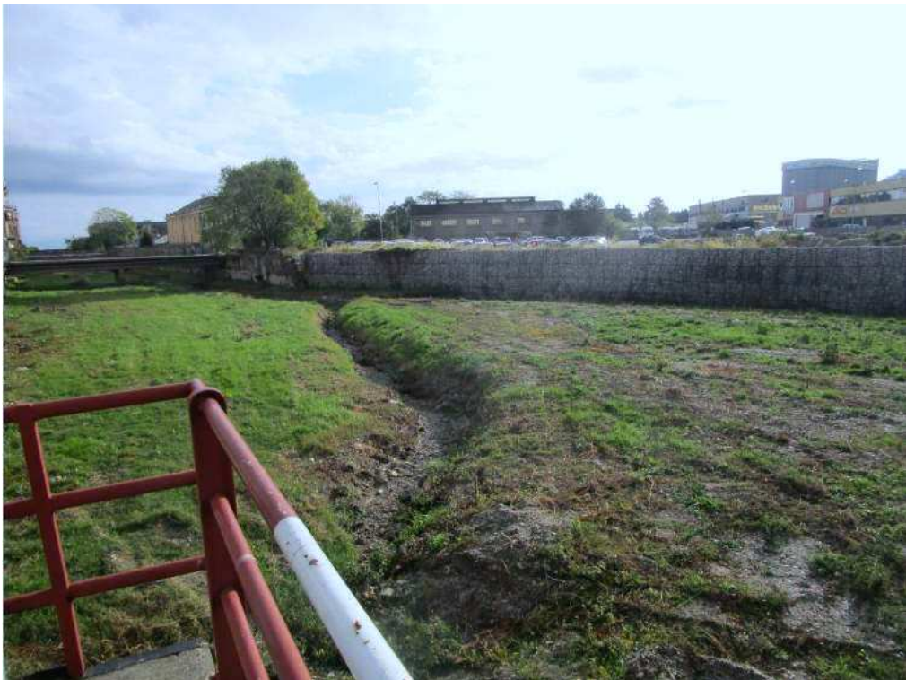
Figura 4 c): Tratto 2 - Vista 2
