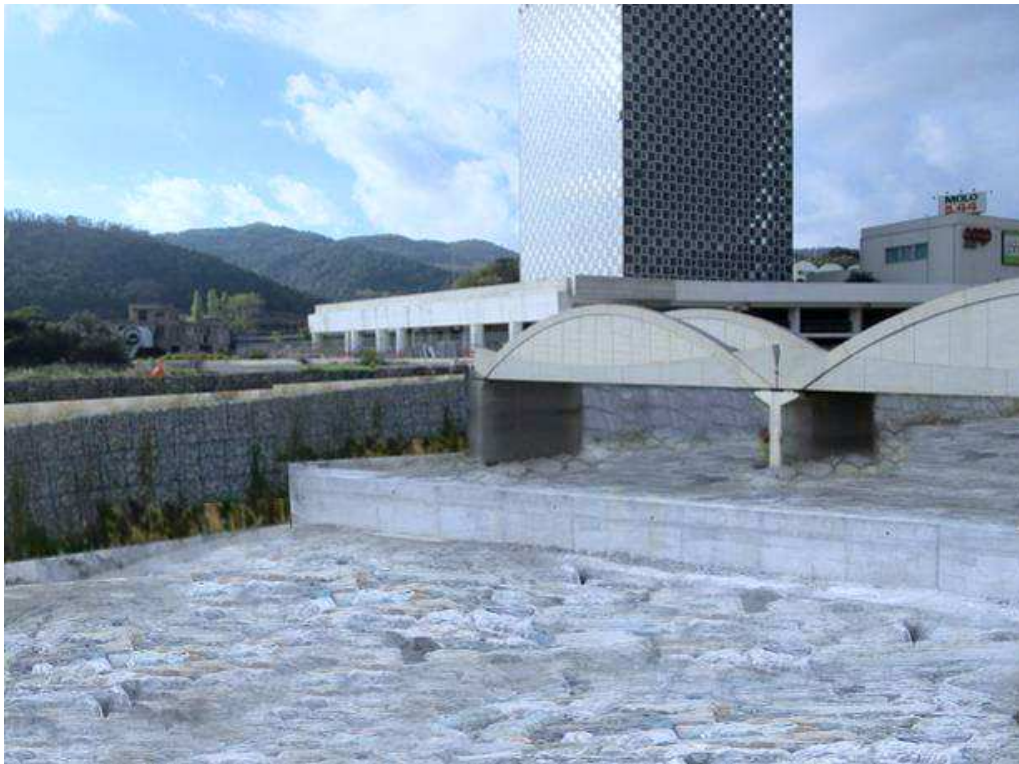
Figura 16 c): Tratto 2 - Vista 1 – Post Operam
