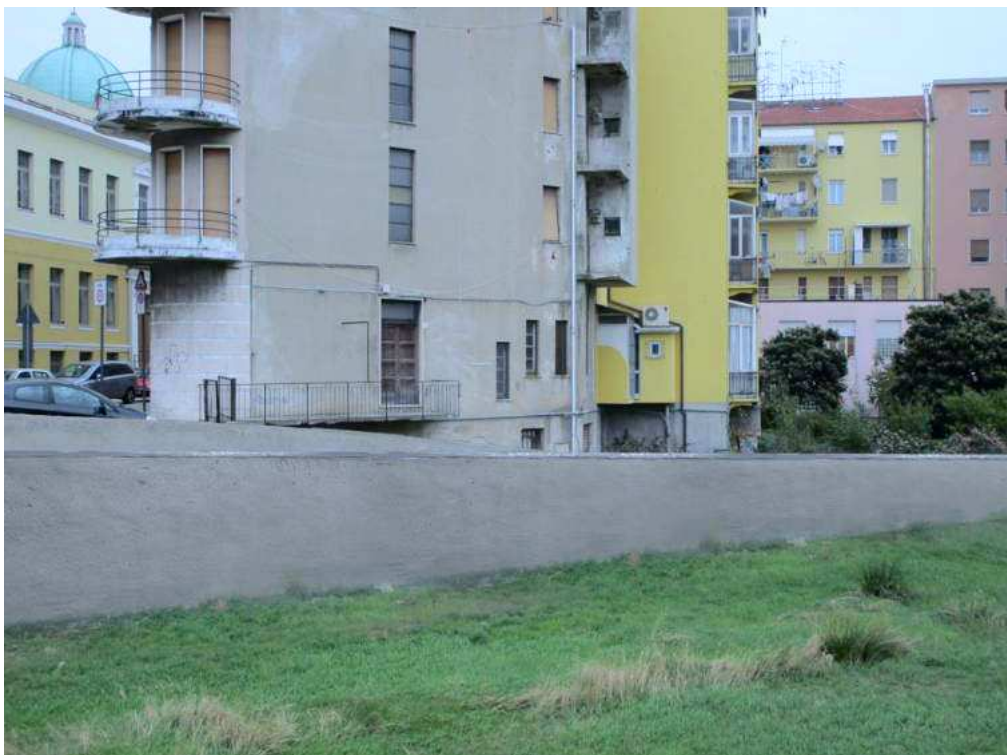
Figura 17 c): Tratto 3 - Vista 5 – Post Operam
