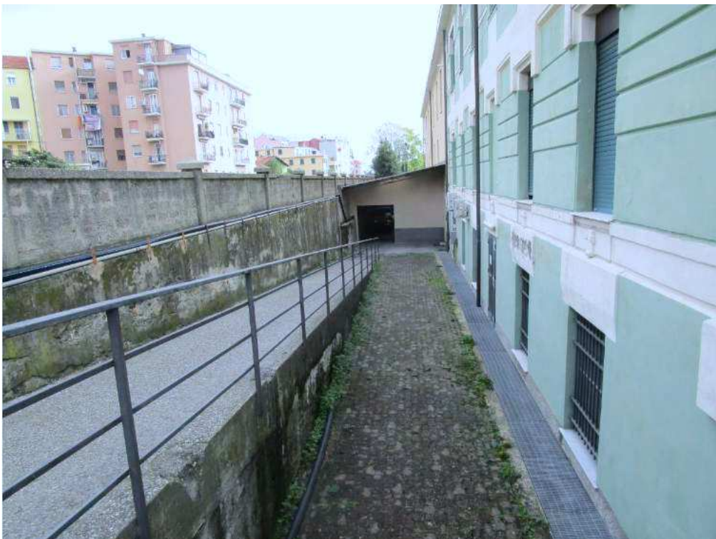
Figura 5 c): Tratto 3 - Vista 2
