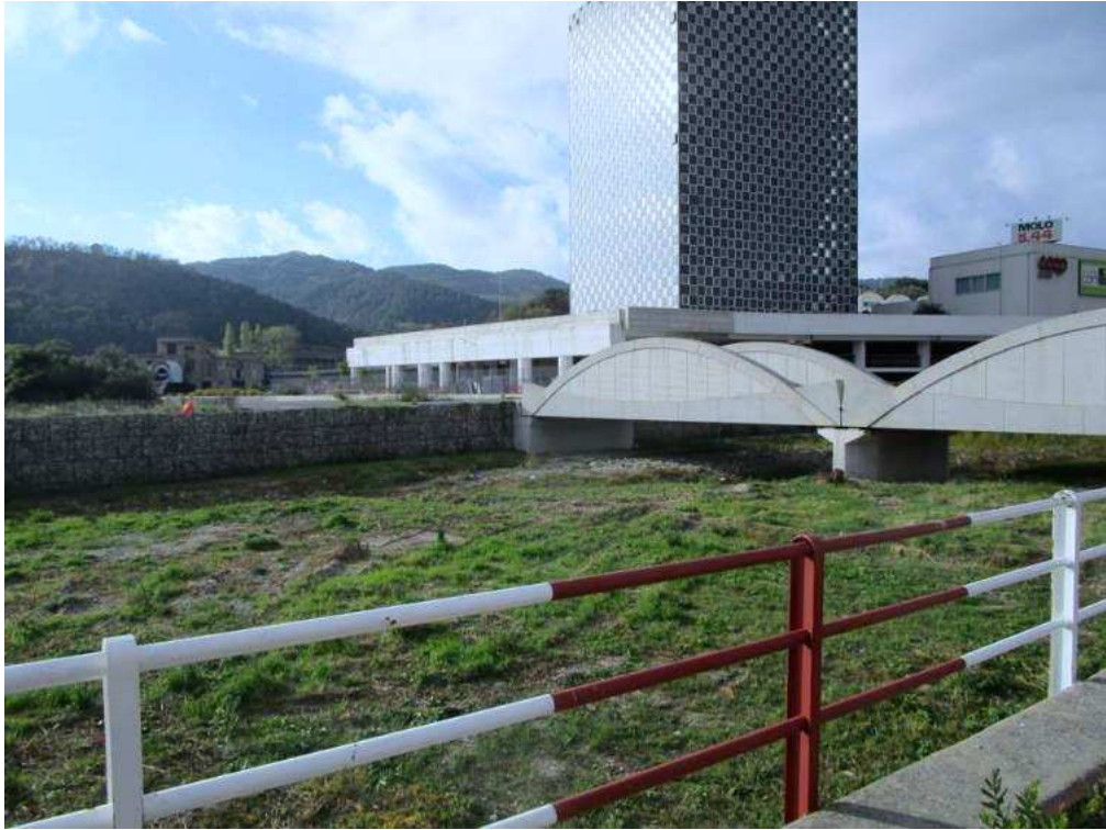
Figura 16 b): Tratto 2 - Vista 1 – Ante Operam
