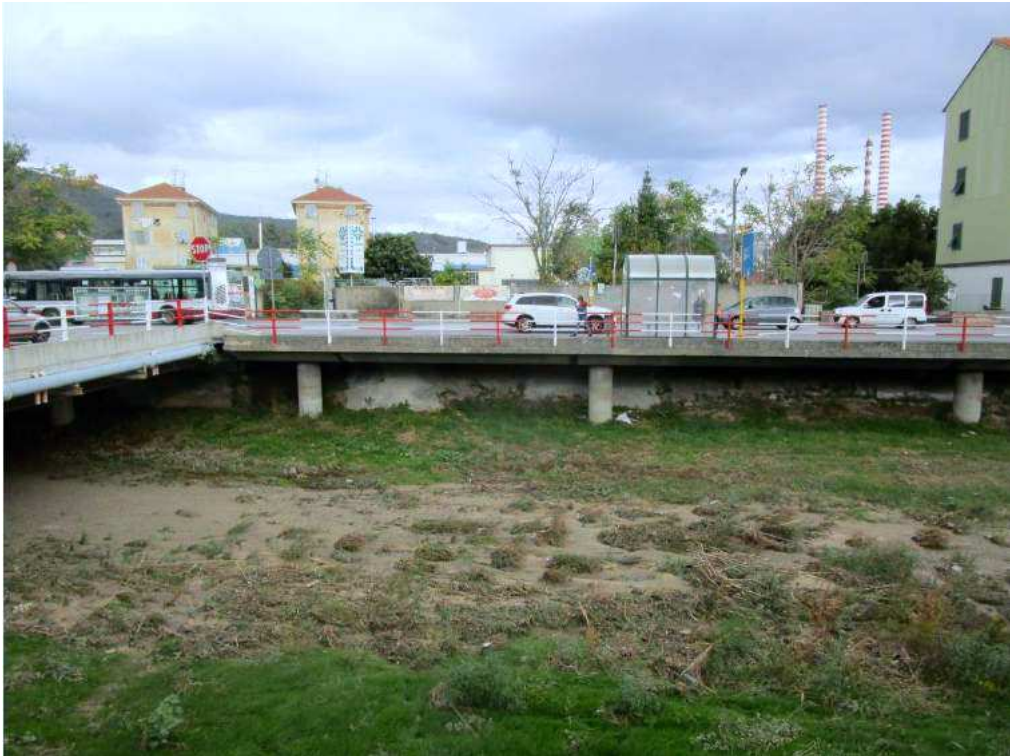
Figura 3 d): Tratto 1 - Vista 3
