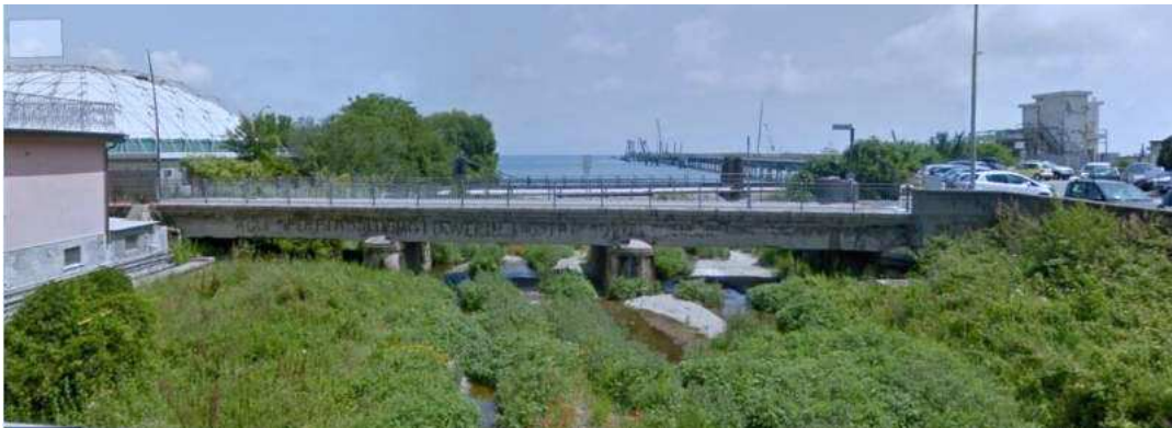
Figura 19 a): Passerella pedonale - Ante Operam
