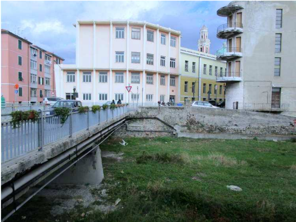
Figura 5 d): Tratto 3 - Vista 3
