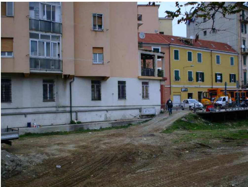
Figura 6 c): Tratto 4 - Vista 2
