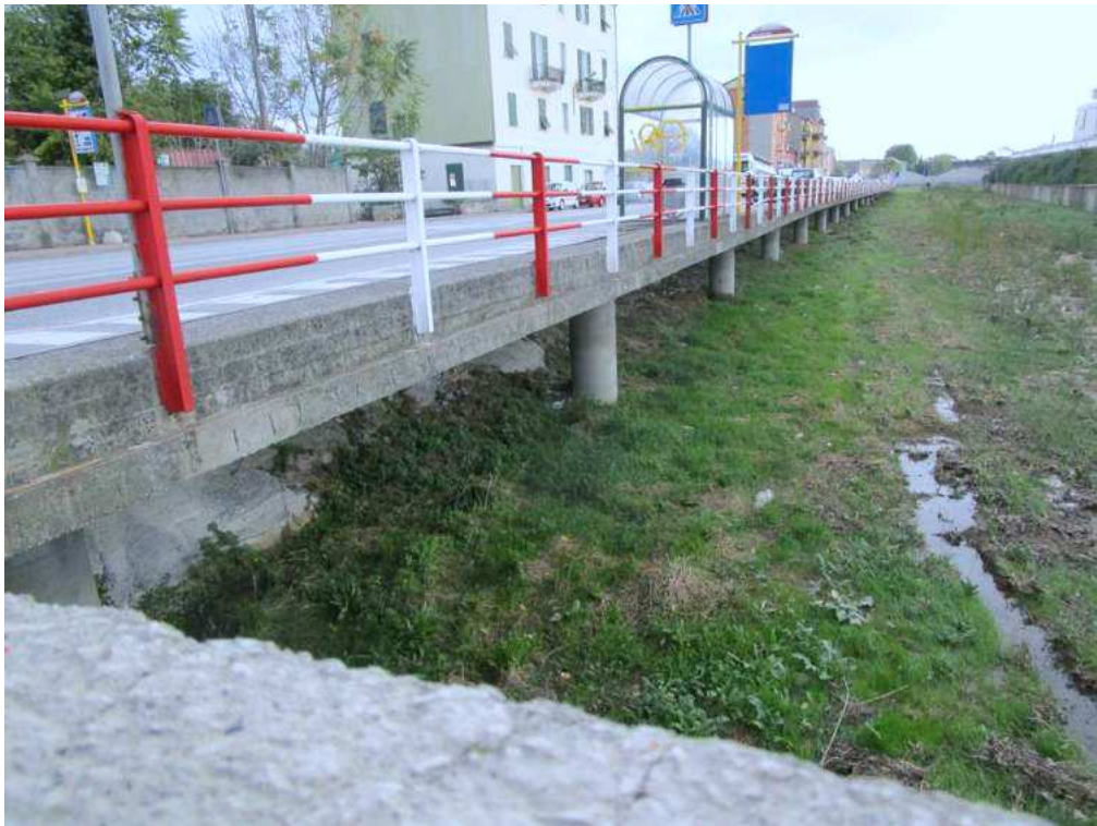
Figura 15 b): Tratto 1 - Vista 1 – Ante Operam
