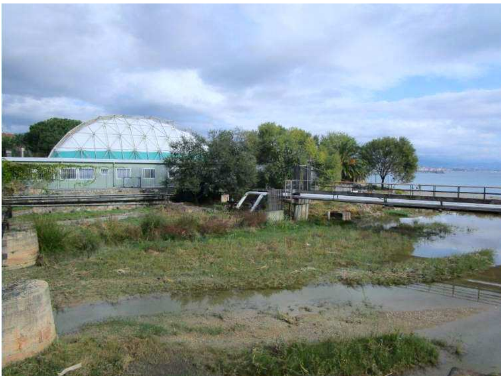
Figura 7 d) Tratto 5 - Vista 4
