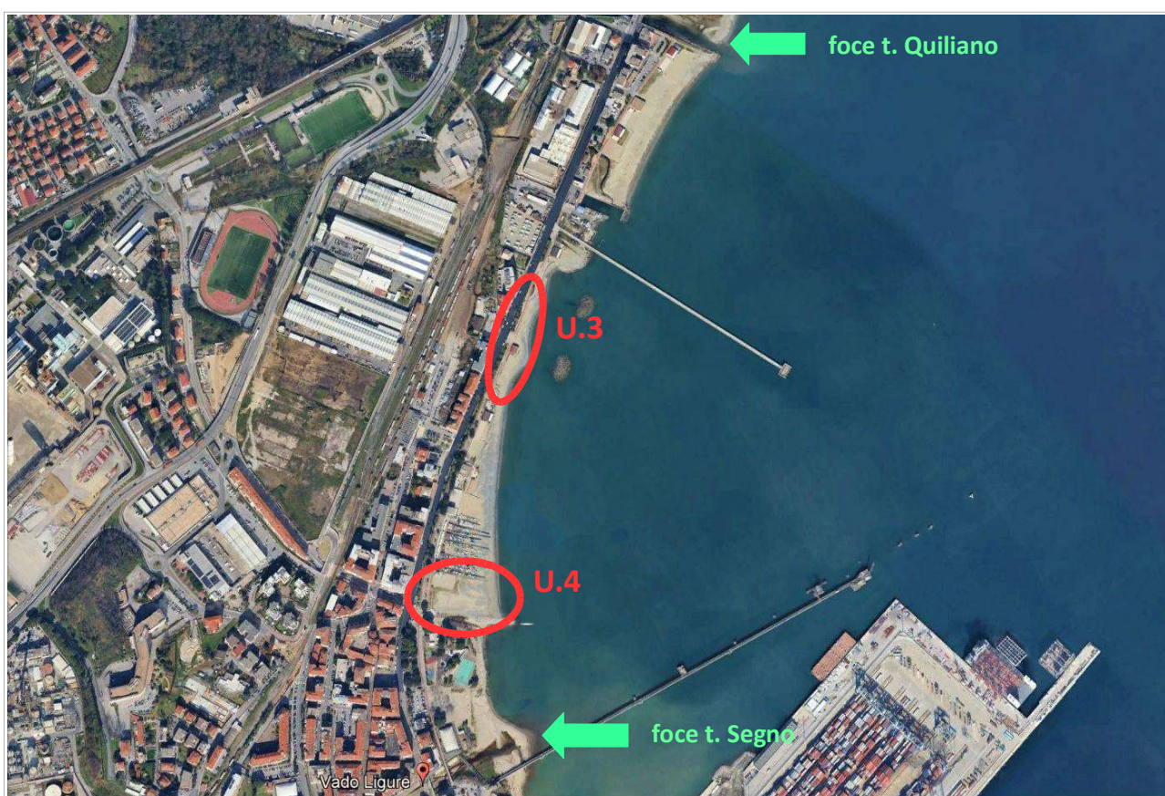
Figura 1: ortofoto con indicazione in rosso delle unità di intervento interessate dalla variante (fonte: Google Earth).
