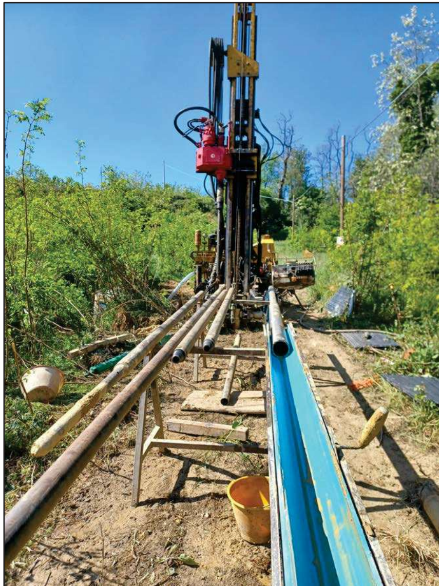
Figura 3.1. Perforatrice idraulica PUNTEL PX 600 utilizzata.
