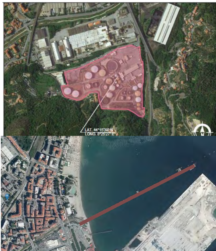
Inquadramento deposito (a) e pontile (b) della Alkion Terminal Vado Ligure S.r.l. su base ortofoto regionale
