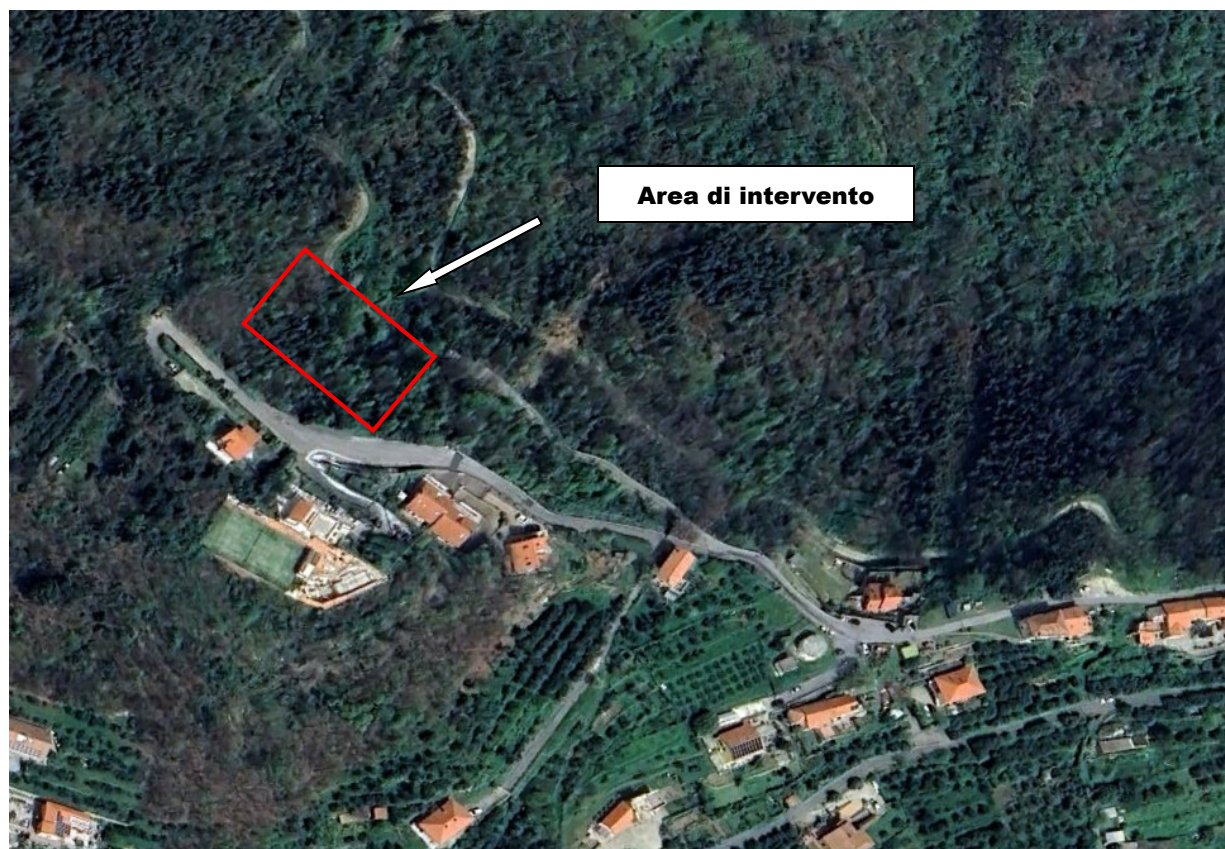
Foto 1 –zona di dissesto principale
