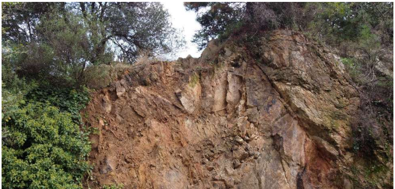
Dettaglio della porzione sommitale, dove è evidente il ciglio di distacco in potenziale arretramento che interessa tutta la fascia eluviale e il substrato roccioso completamente alterato e destrutturato
